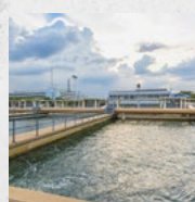
Auffang- und Vorratsbecken
