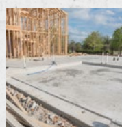
Wand- und Bodenplatten
